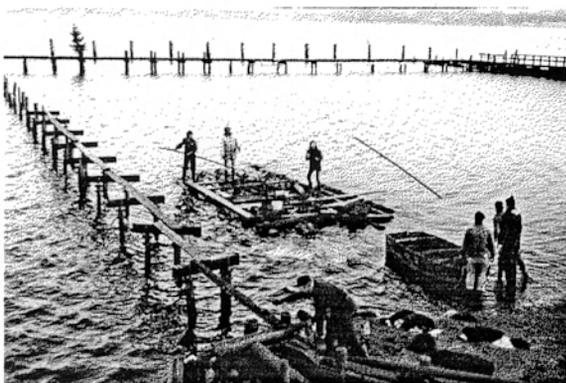
Das Einspülen der Beton-Stegpfähle erfolgte mit selbst gefertigten Spüllanzeln und einer Feuerlöschspritze. Es war eine absolute Knochenarbeit. Aber das Ziel, einen Hafen zu errichten, setzte bei allen
